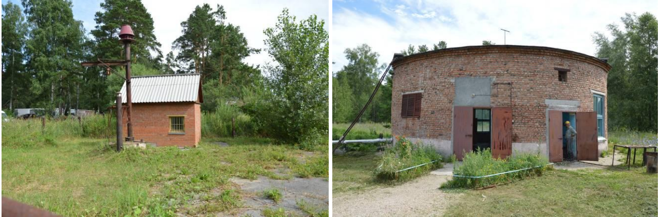
Рисунок 7 – КНС по ул. Строителей (слева), КНС-6/105 (справа)
